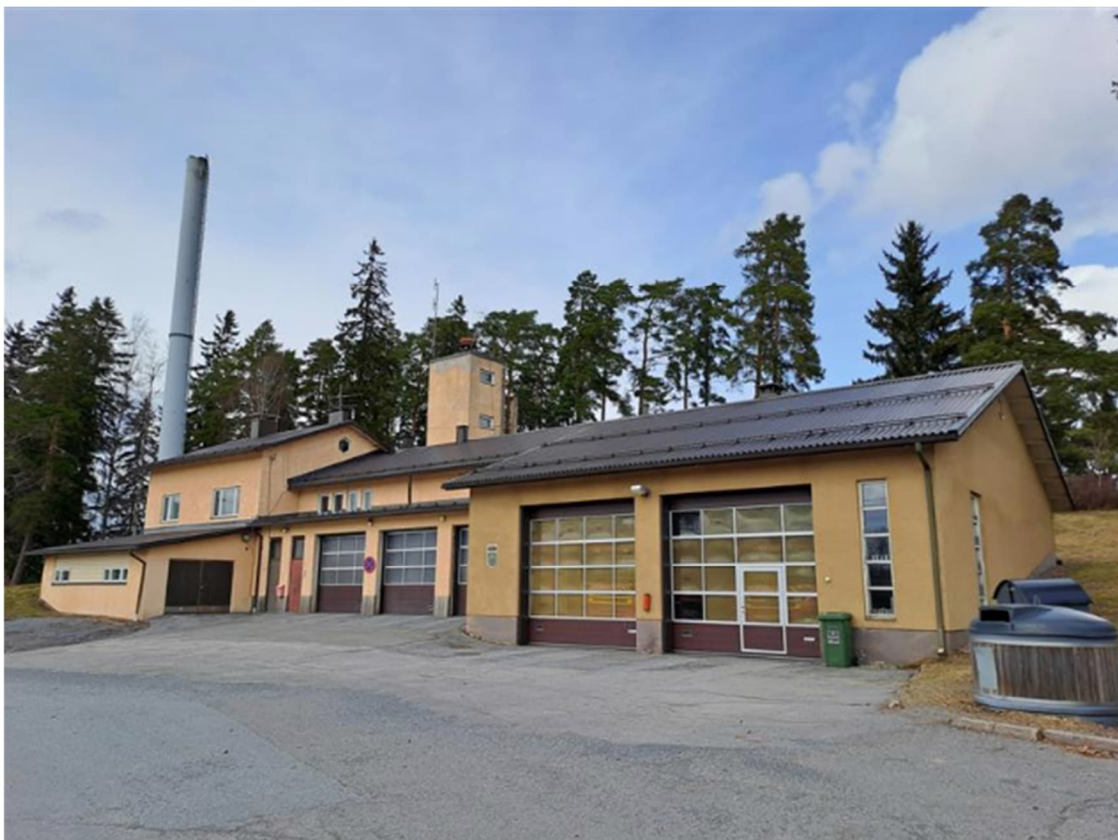
Kuva 8 Paloasema etelästä. (Satakunnan Pakki, Olli Joukio 10.4.2024.)
